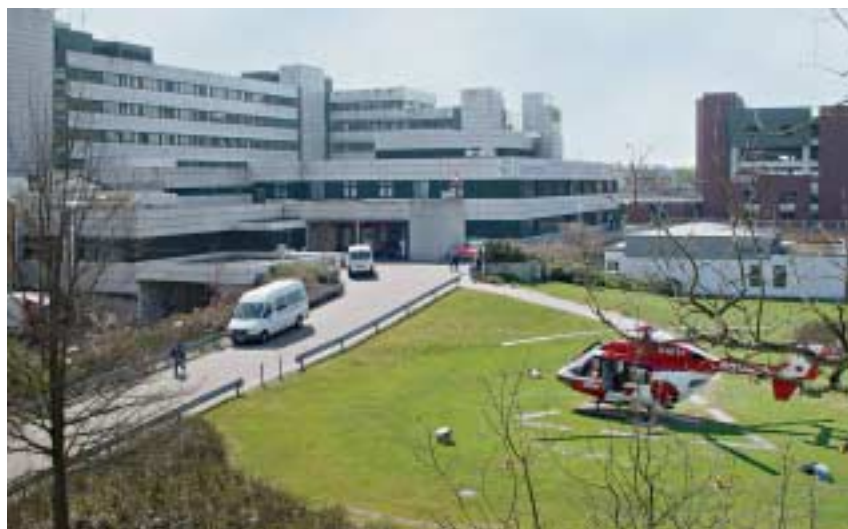
Bild 1: Das Diakoniekrankenhaus Rotenburg/W. nutzt die Planungssoftware ElektroPartner
