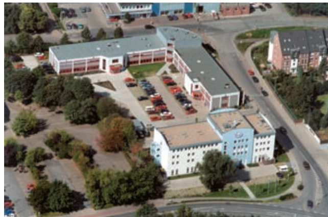
Auf allen Ebenen des Elektroinstallationsmarkts aktiv: Die Firma hausmann wynen
